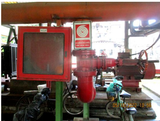
หัวจ่ายน้ำดับเพลิงและสายฉีดน้ำดับเพลิง
