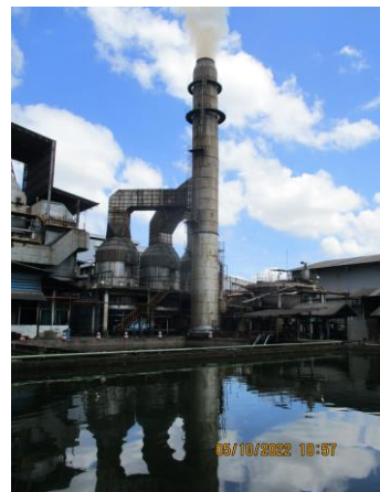
รูปที่ 1 ระบบบำบัดฝุ่นละออง (Wet Scrubber)
