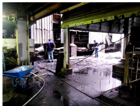
รูปที่ 21 การขุดลอกระบบระบายน้ำ
